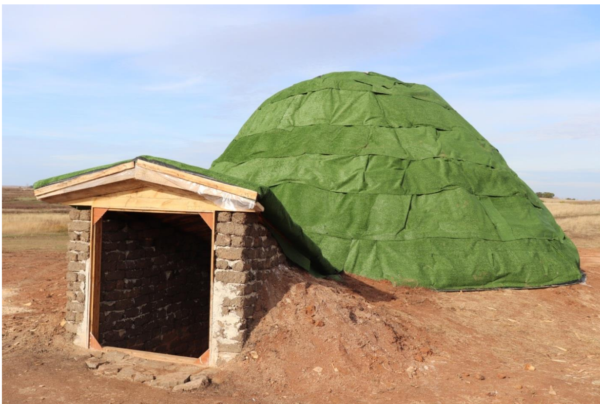
Рисунок 10 - Черепичный принцип укладки и закрепления покрытия.
