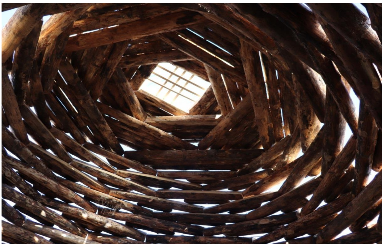
Рисунок 9 - Внутренняя вязь перекрытия.
