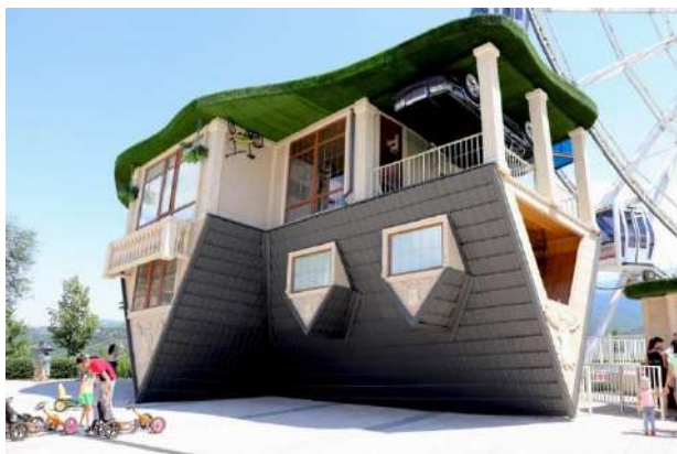
Рис 3. «Перевернутый» дом, г. Алматы
